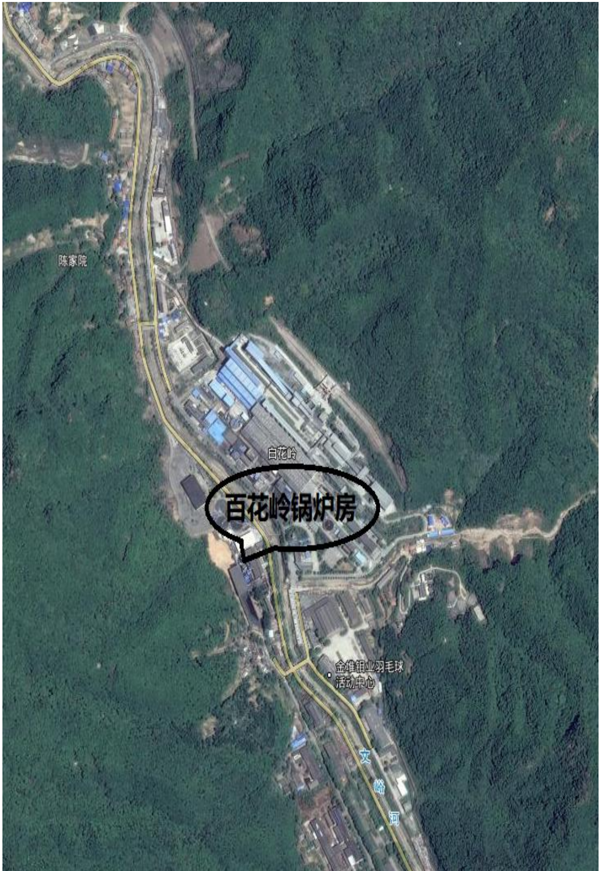
图四 百花岭锅炉房所在地
